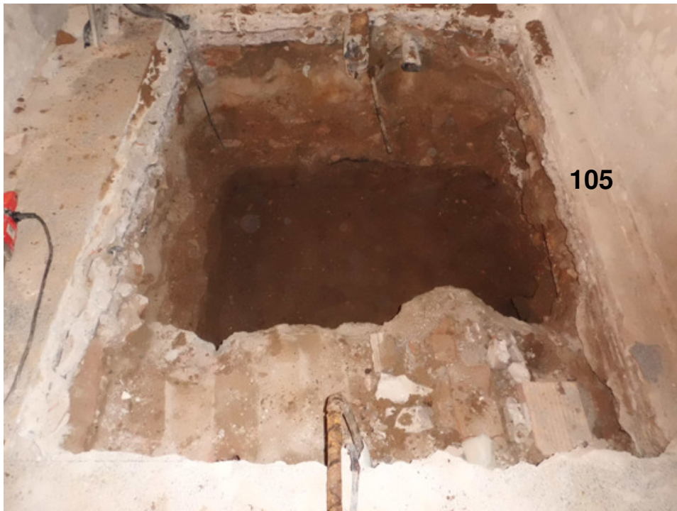
Vista de la fonamentació 105
