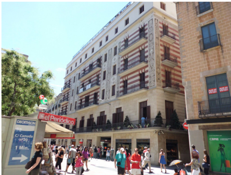
Vista de la finca on s'ha dut a terme la intervenció
