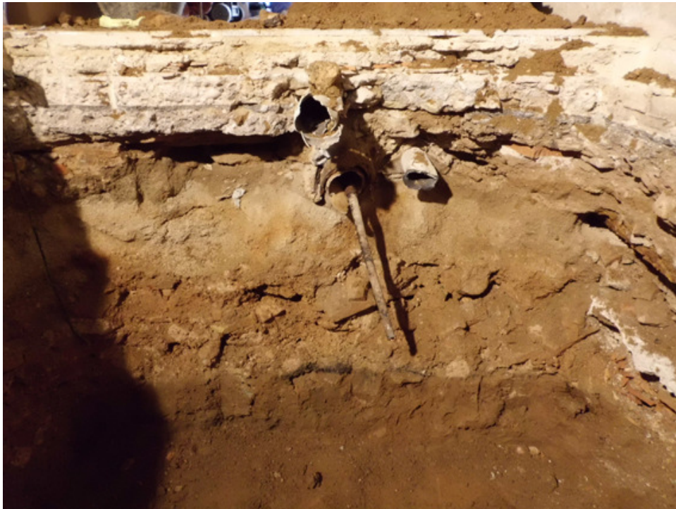
Vista del perfil del fossat de l'ascensor
